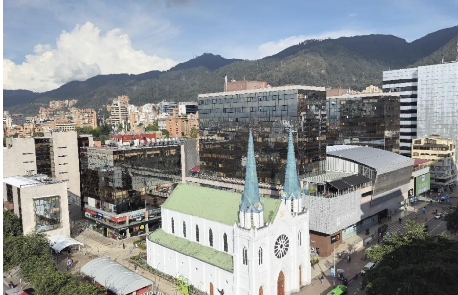
Ilustración 1. Centro Comercial y Financiero Avenida Chile.
