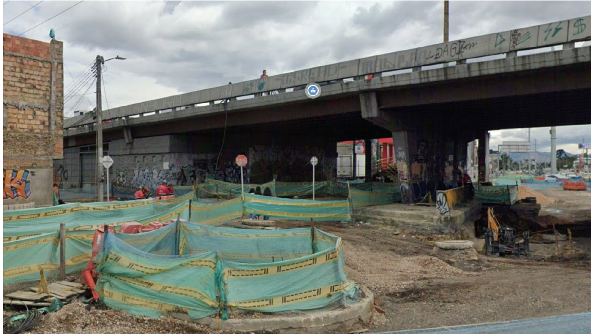
Gráfica 9. Fotografías Bajo Puente Costado Sur-oriental
