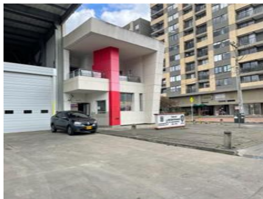
Estación de Bomberos Bicentenario
